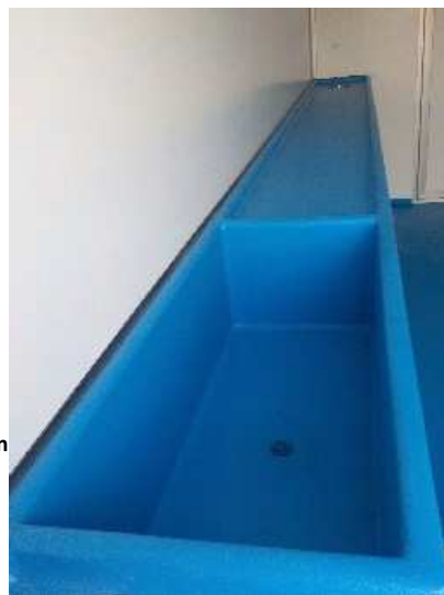
Tisch auf der ganzen linken Seite, mit Waschbecken aus GFK (+ 2 Tank, Ausgießer und 12V Unterwasserpumpe), und Becken für Muscheln
